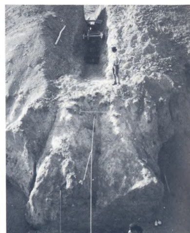
SAINT-TADDEE : Croisement d'une tranchée.
