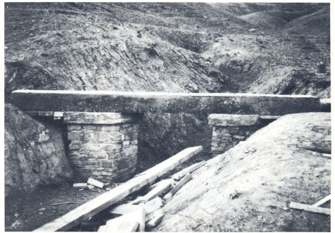
SAINT-TADDEE : Jonction de deux terrains irrigués.
