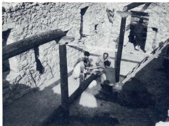
KESSAB : Restauration d'une Eglise villageoise. 1986.
