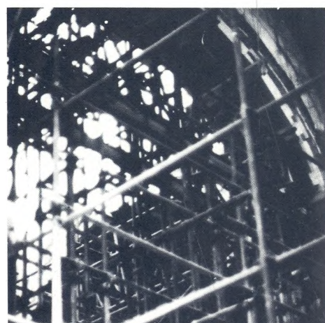
SAINT-TADDEE : Étayage des voûtes de la grande Eglise.
