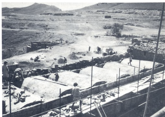
SAINT-TADDEE : Restauration de l'enceinte sud et consolidation des voûtes. 1977.
