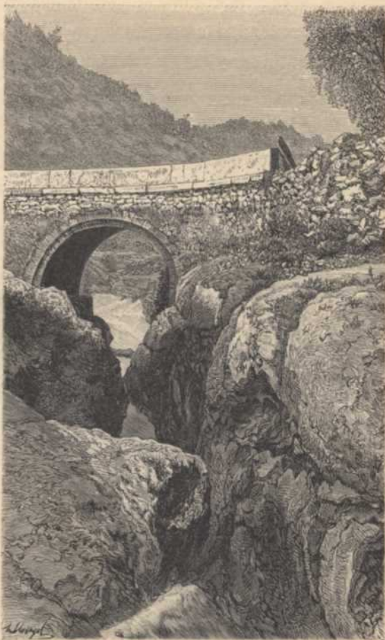
PONT DIT « AGHA-KEURPISSI ».
