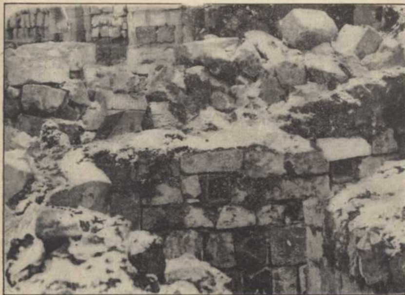
Le siège d'Aïn-Tab. — Tranchée couverte de 2 e ligne turque (Vue prise après la destruction partielle de l'ouvrage).
