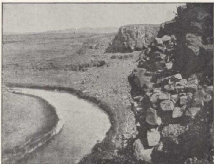
Près de la crevasse de l'Arpa-Tchaï à l'endroit où d'après le plan le réservoir aurait du être construit.
